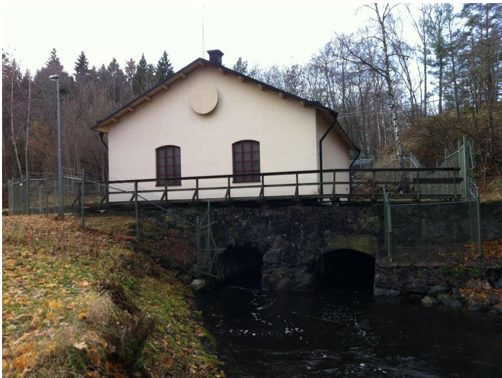
Figur 5. Många gamla småskaliga kraftstationer drivs än idag. Här Uddby kraftverk (nedströms Albysjön, Tyresta) anlagt 1898. Foto: Ingemar Näslund.
