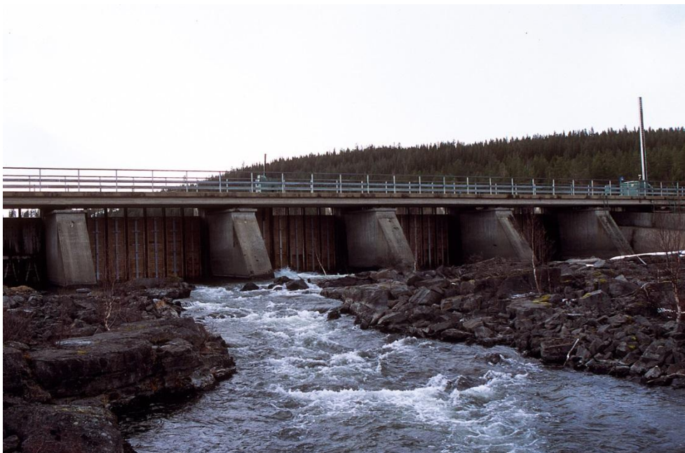
Figur 13. Regleringsdammen vid Bågede i Faxälven. Byggt 1955, ursprungligen enbart för reglering av sjöarna uppströms. Sedan 1974 finns också ett kraftverk i Bågede. Foto: Ingemar Näslund.
