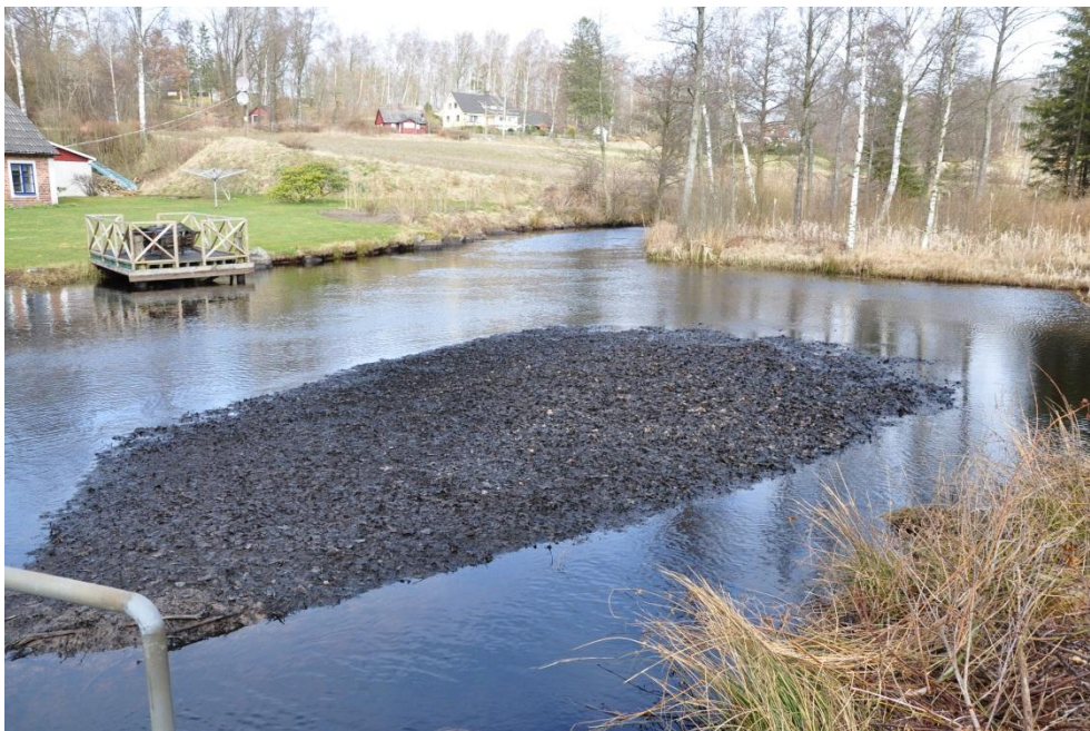
Figur 39. Sedimentation i ett dämningsområde till ett småskaligt vattenkraftverk i Smedjeån (Lagan). Foto: Johan Kling.
