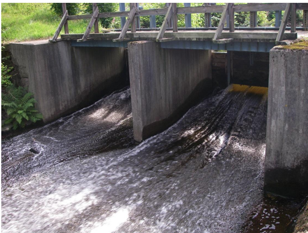
Figur 14. Damm i Busjöån, Ydre, Östergötland. Foto: Jakob Bergengren.
