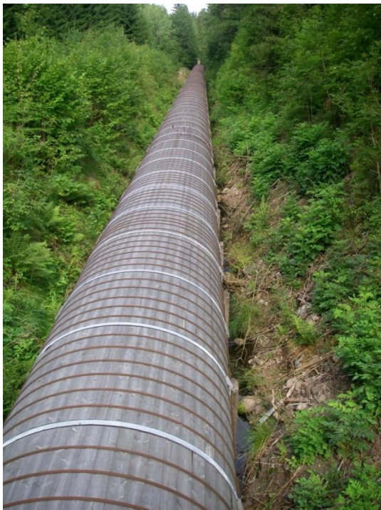
Figur 9. Trätuben till kraftverket i Busjöån, Ydre. Foto: Jakob Bergengren.
