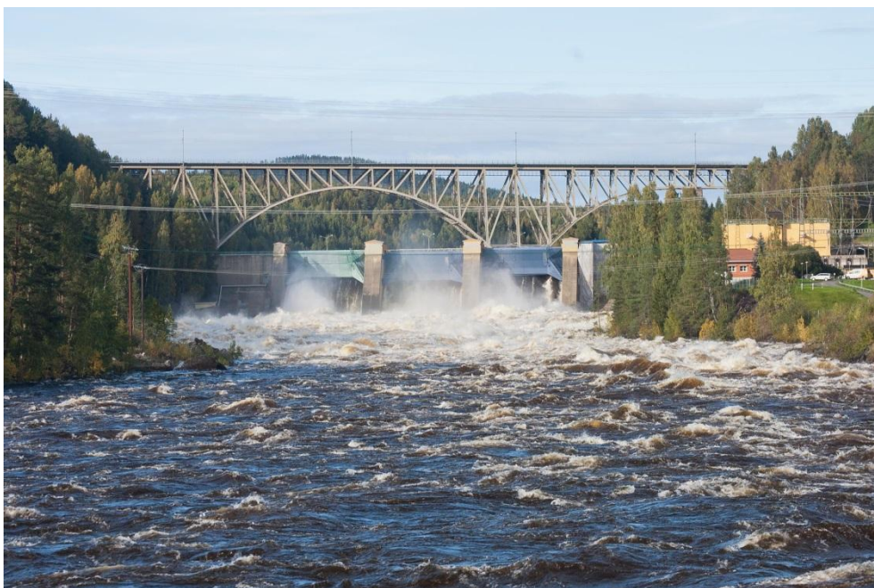
Figur 28. Tappning av överskottsvatten vid Forsmo kraftverk i Ångermanälven den nederbördsrika hösten 2011. Foto: Ingemar Näslund.
