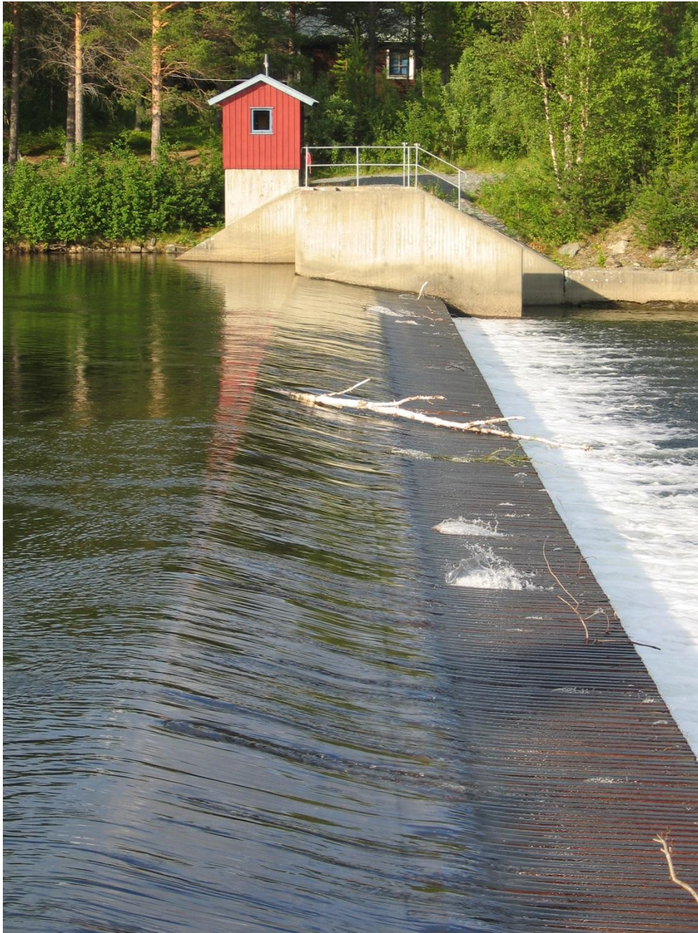
Figur 18. Fiskspärr i Storån nedströms Ottsjön (Indalsälven). Foto: Ingemar Näslund.
